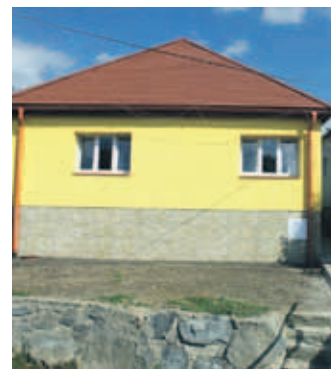
Zrekonštruovaná budova zdravotného strediska v Likavke.
