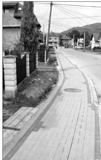
Zrekonštruovali sme hlavný chodník v obci, ktorý bol v havarijnom stave. Poznačil ho zub času.
