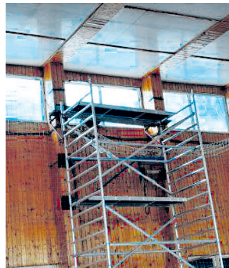
Výmena okien v školskej telocvični.
